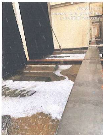
ระบบ Cooling ที่ทำการตรวจเช็คระบบ ตรวจเช็คค่า Conductivity Cooling 0.95 Ms
